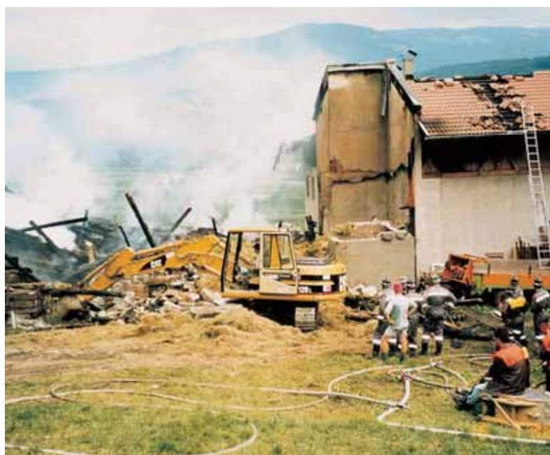
Fig. 16 - Il muro tagliafuoco non ha assolto la sua funzione
